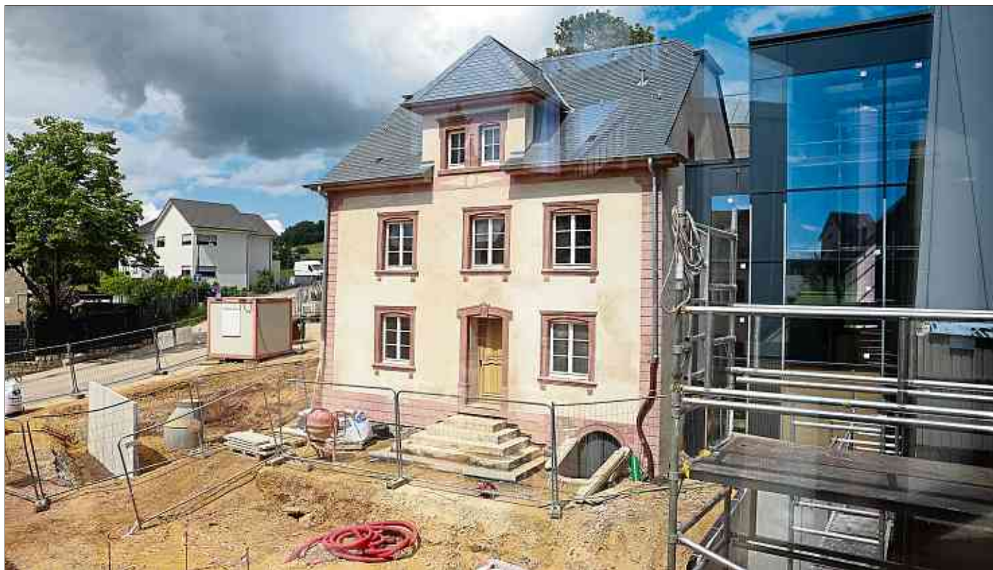
Das frühere Wohnhaus ragte im Juni aus der Baustelle hervor. Nun ist es Teil des Schulkomplexes.
