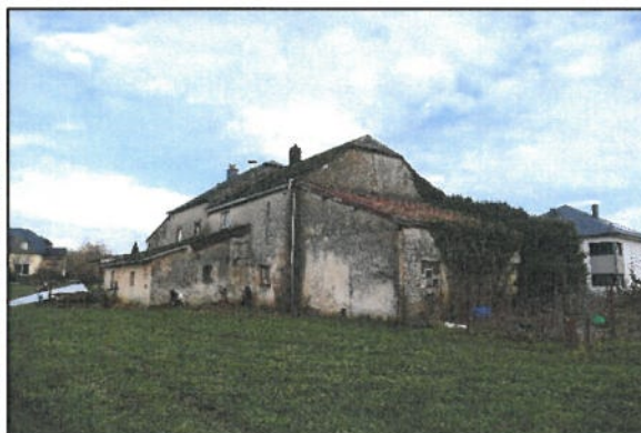
Fig. 2.6: Bâtiment vu du sud-ouest
