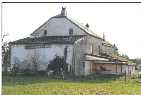
Fig. 2.7: Vue du nord. Une niche sert comme abri pour chèvres
