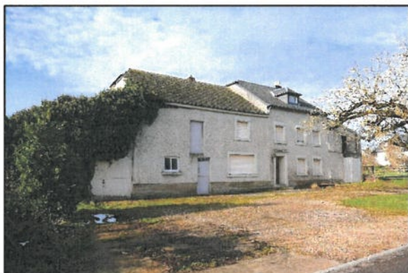
Fig. 2.5: Vieux bâtiment de ferme sur la parcelle 559/1743, vue du sud-est
