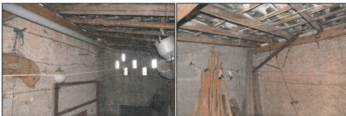
Fig. 2.10: Intérieur de l'ancien atelier (annexe du côté nord du bâtiment)
