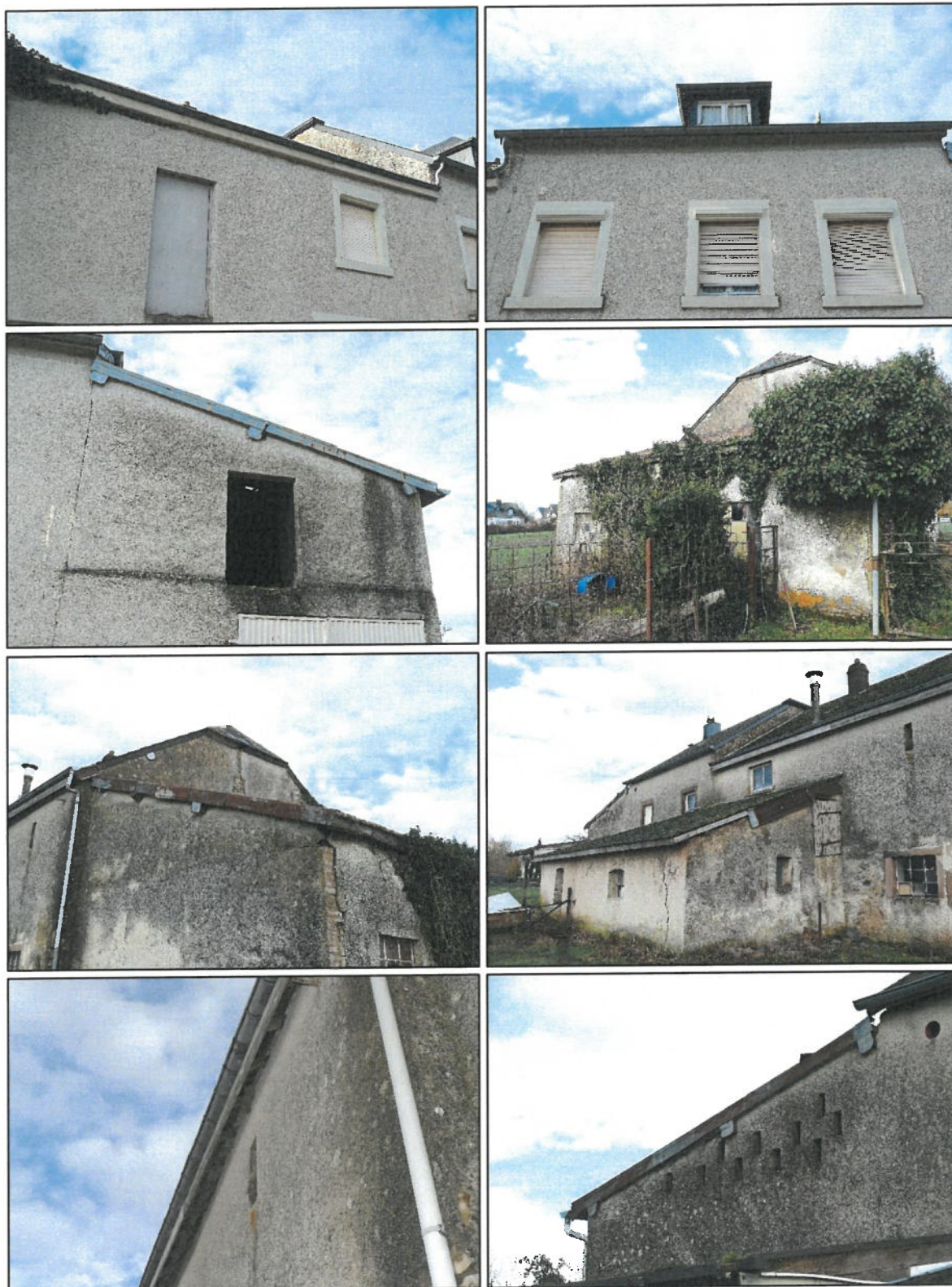
Fig. 2.9: Aspects du bâtiment de ferme sur la parcelle 559/1743 et notamment du surplomb du toit
