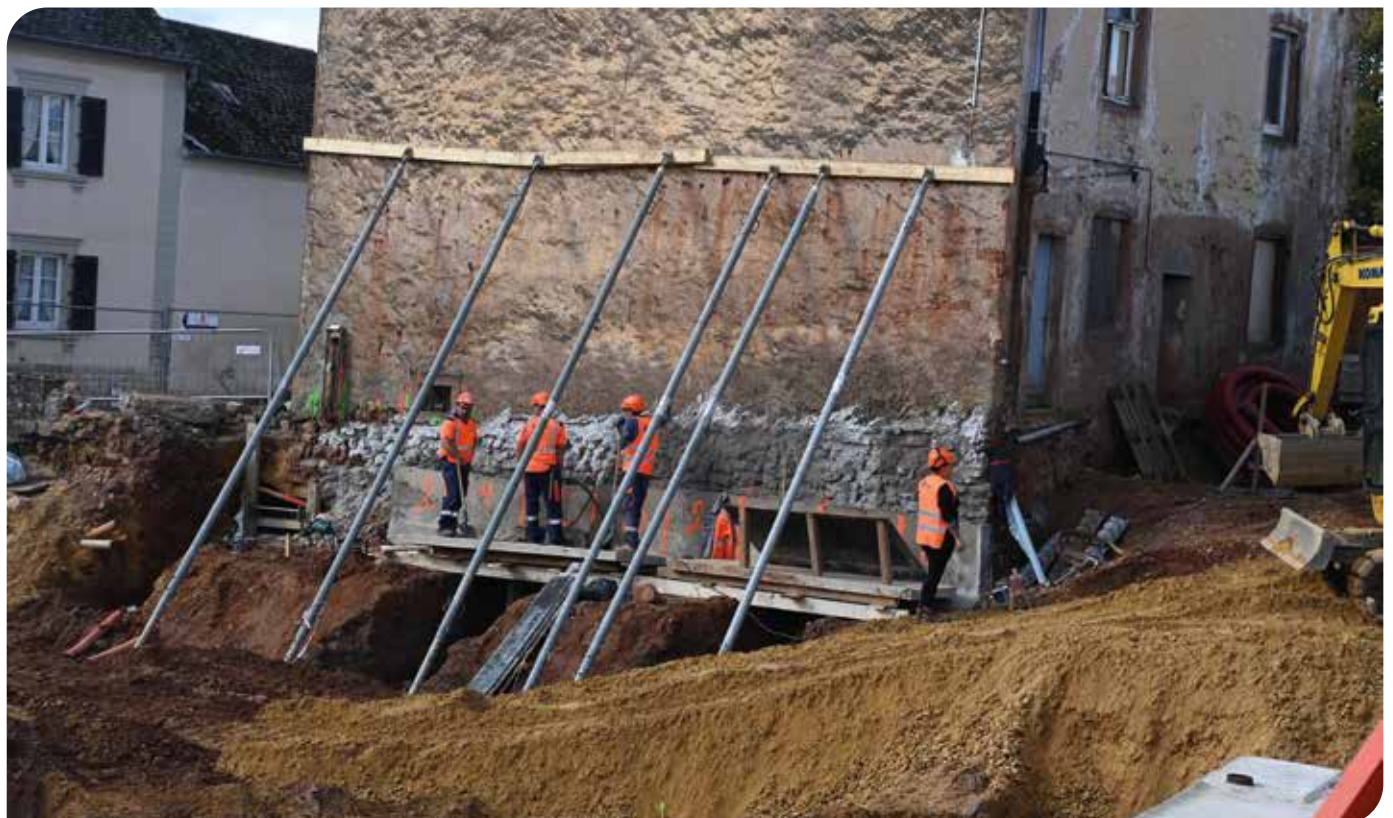
Reprise en sous-œuvre vum nationalgeschützten Harpes Haus
