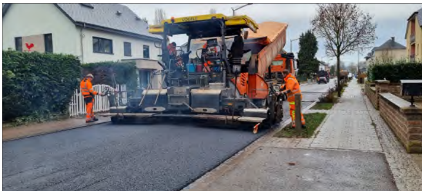
Erneuerung vun der Hauptstrooss N12 zu Platen am Dezember 2022
