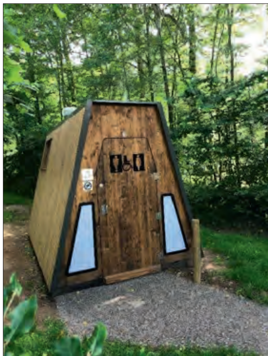
Toilett am Rëmmerbësch
