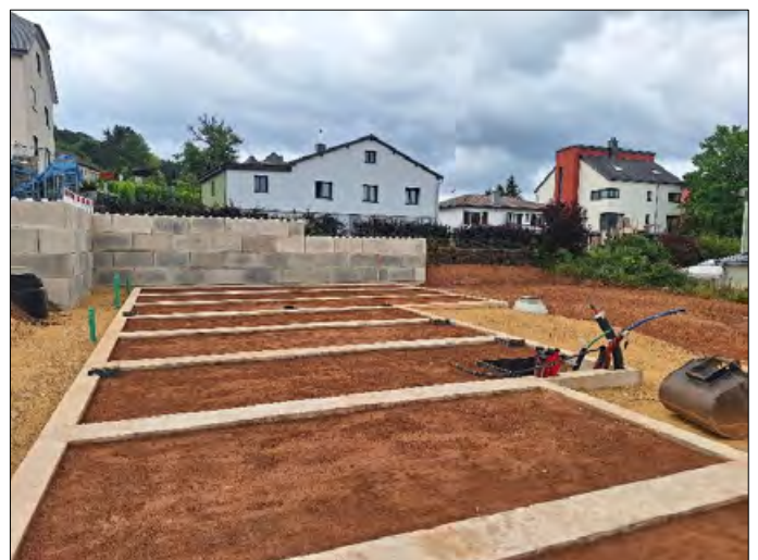
Fundamenter op der neier Plaz beim Kierfent si prett fir d'Modulgebai
